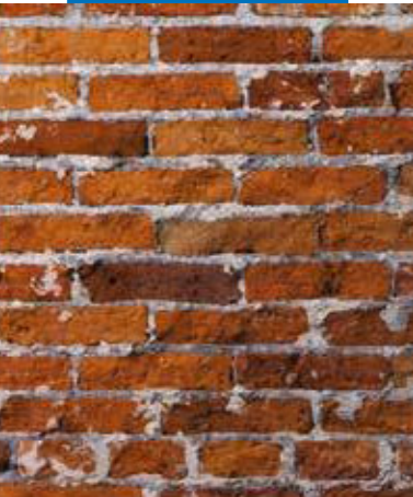
Muratura in mattoni dopo la rimozione dell'intonaco degradato
