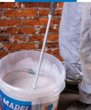
Preparazione di Mape-Antique Rinzafo
