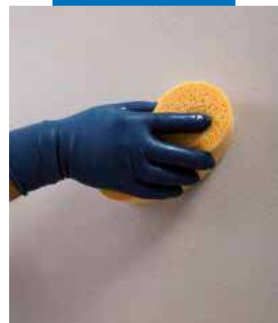
Rifinitura con spugna di Mape-Antique FC Civile
