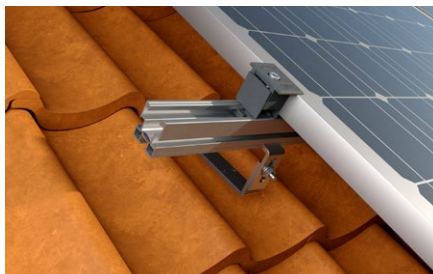
Copertura inclinata con rivestimento in tegole.
