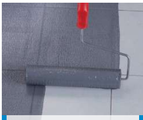
Applicazione a rullo di Eco Prim Grip Plus su pavimento preesistente in piastrelle di gres porcellanato
