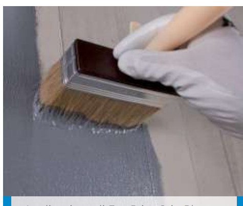
Applicazione di Eco Prim Grip Plus con pennellina su supporto in calcestruzzo
