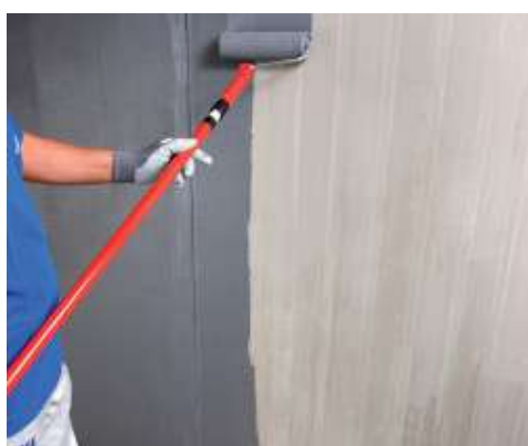
Applicazione di Eco Prim Grip Plus a rullo su supporto in calcestruzzo
