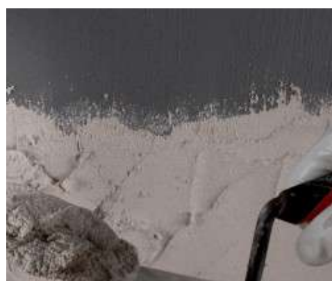
Applicazione di intonaco su Eco Prim Grip Plus
