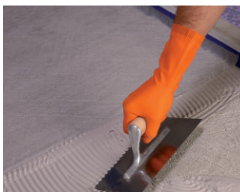
Stesura del primo strato di Monolastic armato con Mapetex Sel N su nuovo massetto
