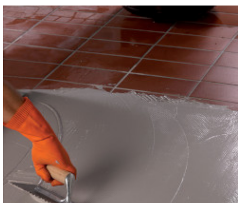
Stesura del secondo strato di Monolastic su Mapenet 150
