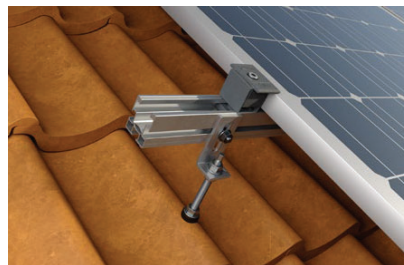
Copertura inclinata con rivestimento in tegole
