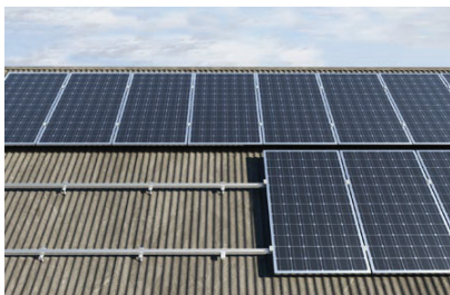
Copertura inclinata con rivestimento in lastre ondulate
